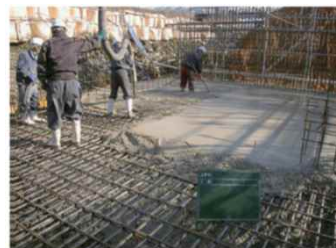
コンクリート打設
