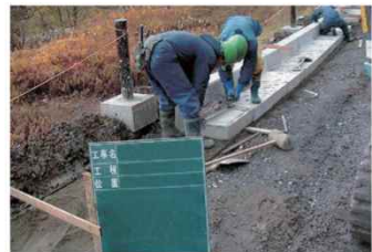
プレキャスト側溝据付
