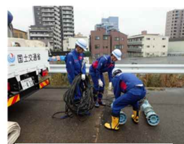
排水ポンプ設置
