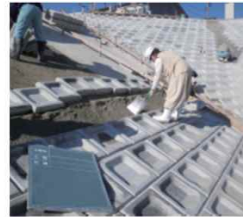
コンクリートブロック設置
