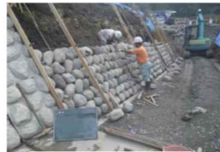
法面石材敷設
