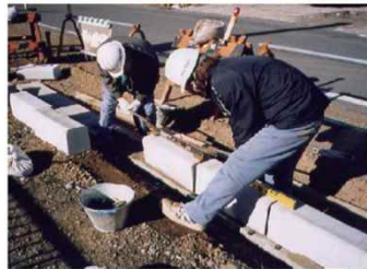
コンクリートブロック敷設
