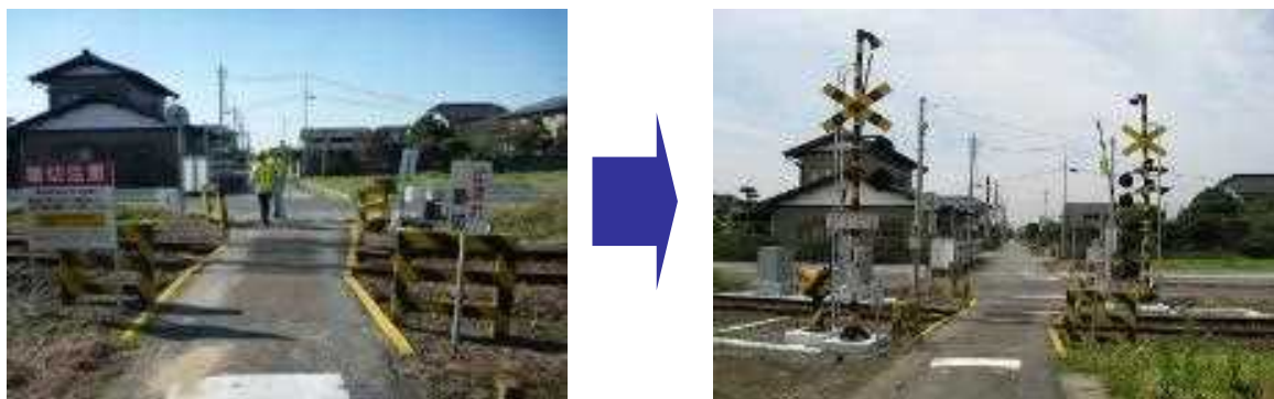
図29：遮断機・警報機の整備
