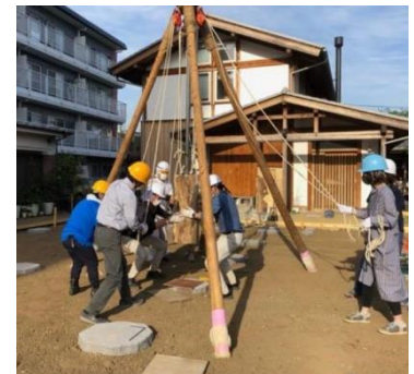
開放的な床下（石場建て）
