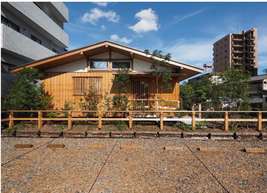
市街地景観の中で伝統的な軸組と板壁を採用した外観
