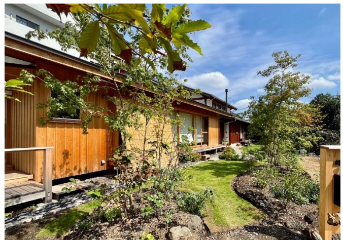
敷地全体に表土を残し土地の健全化を目指した外構
