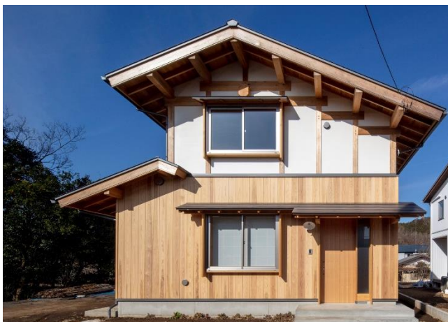
杉の厚板による板張り壁と漆喰壁のシンプルな構成
