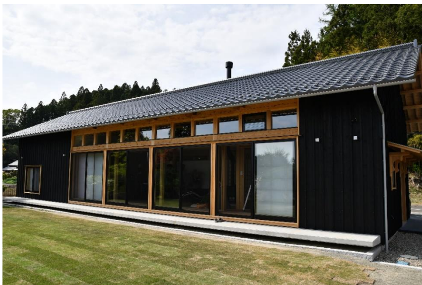
地域の集落に調和し地形に配慮した現代的な外観
