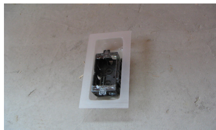
写真 5.5.5 気密コンセントボックスの例
