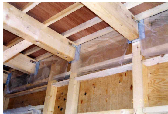
写真 5.2.3 先張り防湿フィルムの施工例 2
