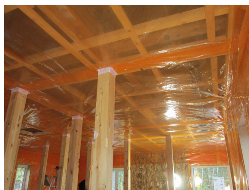
写真 5.2.4 天井の防湿フィルムの施工例
