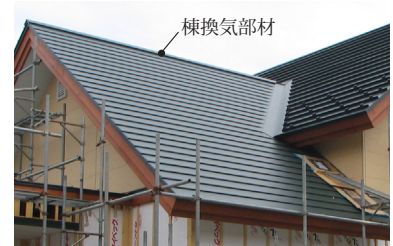
写真 5.1.5 棟換気併用軒天換気方式の例
