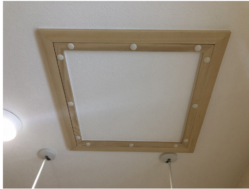
写真 5.5.6 気密点検口による断熱気密化の例
