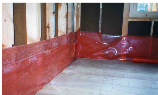
写真 5.2.1 先張り防湿フィルムの施工例
