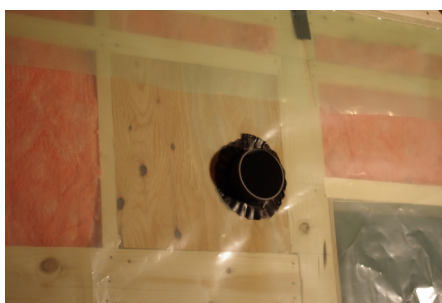
写真 5.5.3 換気孔貫通部の気密化例
