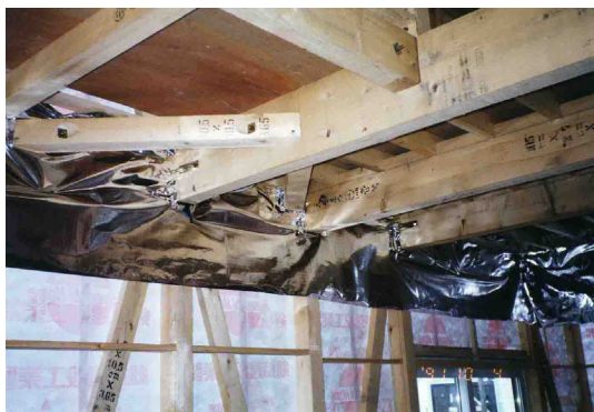
写真 5.2.2 先張り防湿フィルムの施工例 1
