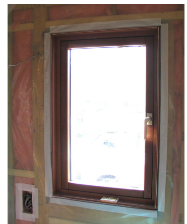
写真 5.6.1 開口部の気密化例
