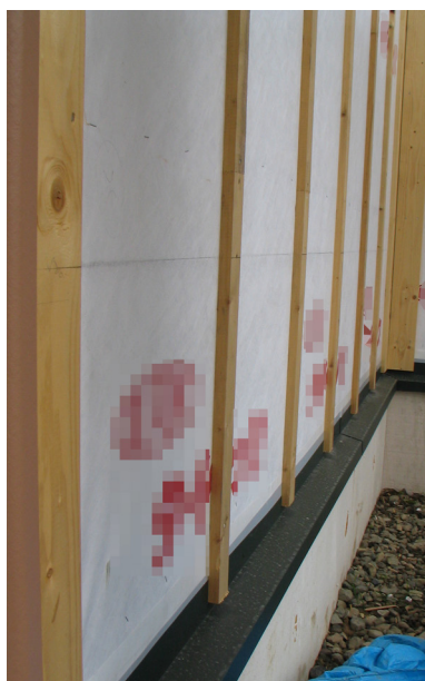
写真 3.2.5 透湿防水シートの施工例
