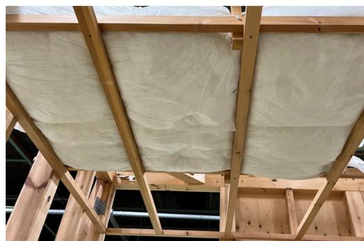
写真C 防湿フィルムを小屋裏側に向けて設置した天井施工の例
