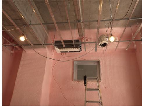
写真 4.3.1 吹付け断熱工法の施工例
