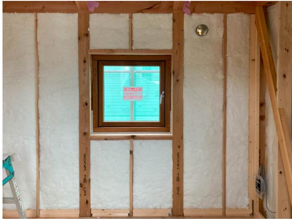
写真 4.2.3 開口部まわりの断熱施工
