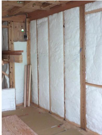
写真 4.2.1 外壁の断熱施工
