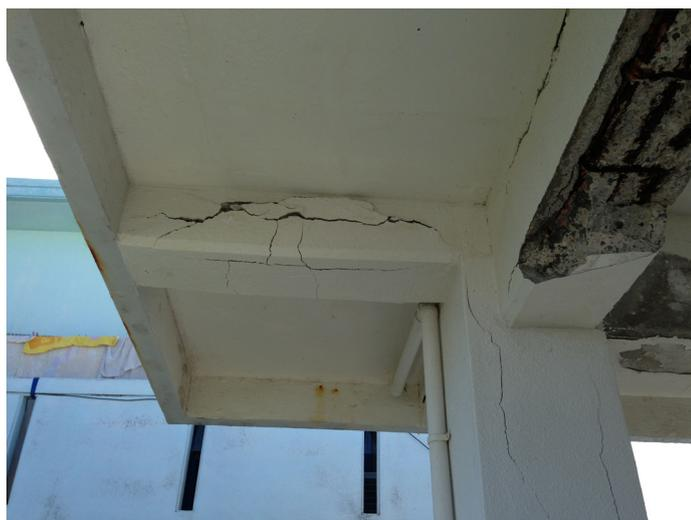
写真 2.2.7 コンクリートの劣化：剥離・剥落、鉄筋の断面欠損の状況
