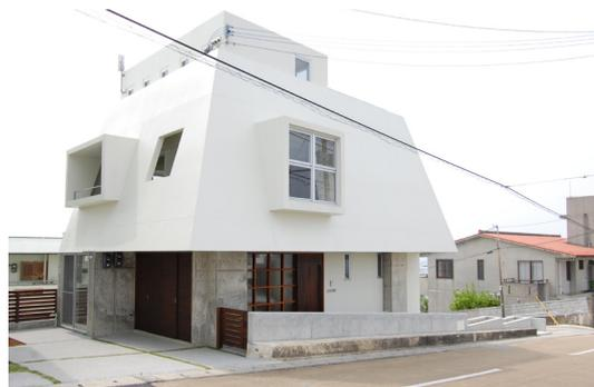
写真 3.6.4 屋根、壁面に遮熱塗料を塗布
