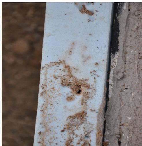
写真 2.2.11 断熱材の被害
