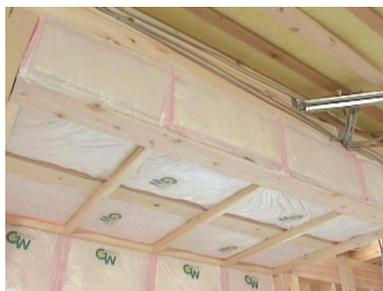
写真 4.2.5 断熱材の施工が完了
