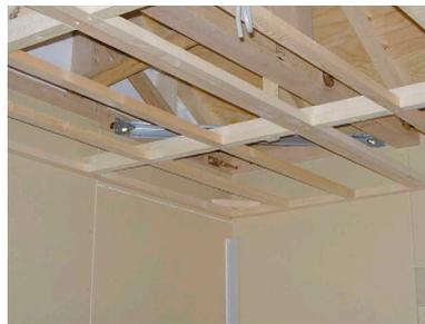
写真 4.2.4 天井の野縁の施工
