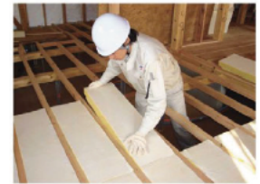
断熱材の切断と施工
