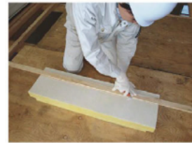
断熱材の切断と施工
