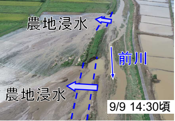
○ 前川の堤防決壊(応急復旧中)
