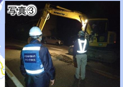
国道249号啓開作業
