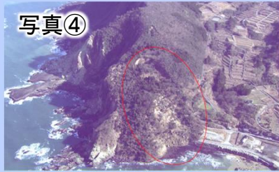
国道249号トンネル坑口崩落
