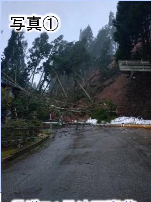
県道51号法面崩落
