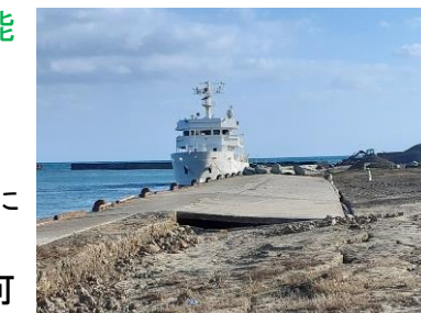
水深4.5m岸壁への着岸状況(5日)
