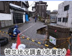
被災状況調査(志賀町)
