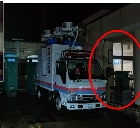
電源供給により停電を解消 (珠洲市 旧日本小学校)
