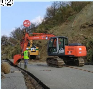
国道249号作業状況
