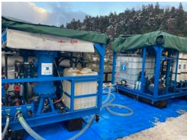
8日(月) 設置状況
