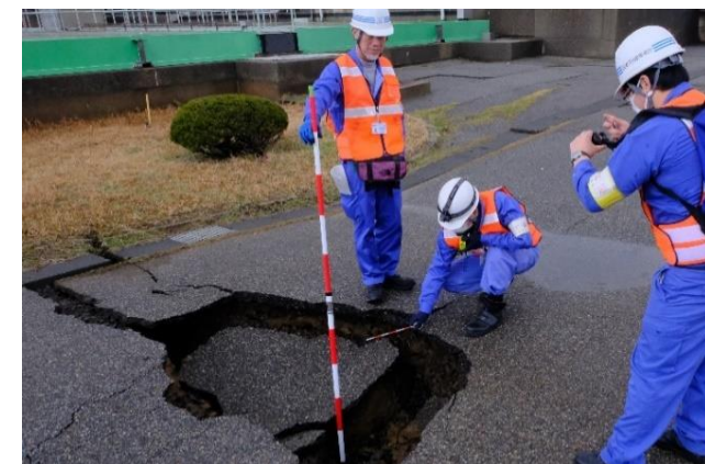
▲日本下水道事業団による調査の状況
