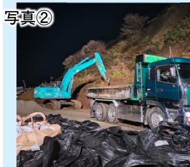
国道249号作業状況
