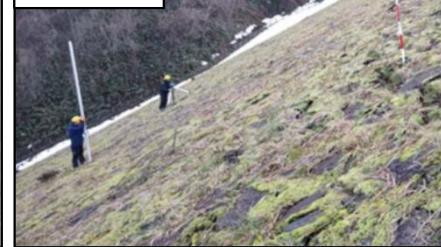
堤体変位測量
