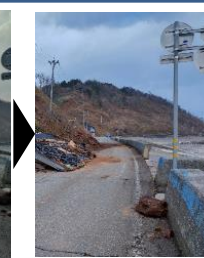
土砂崩落復旧後
