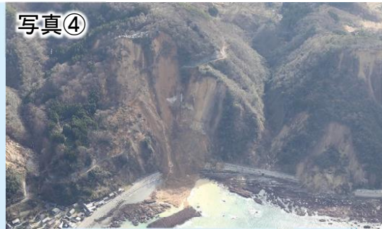
国道249号法面崩落
