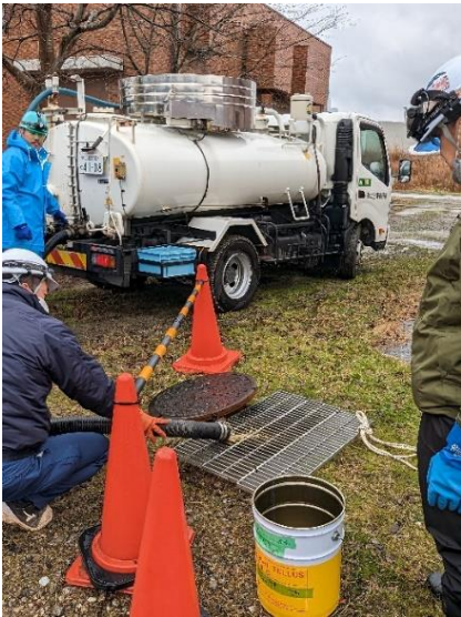
避難所仮設トイレのし尿受け入れ(七尾市)
