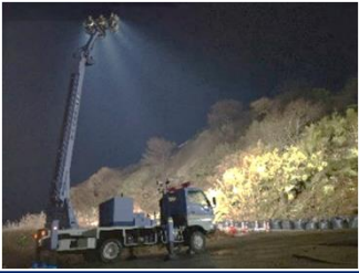
照明車 輪島市 夜間照明
