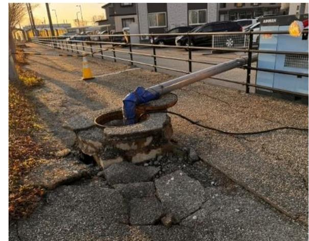
▲仮設配管・ポンプを設置した応急対応の状況
