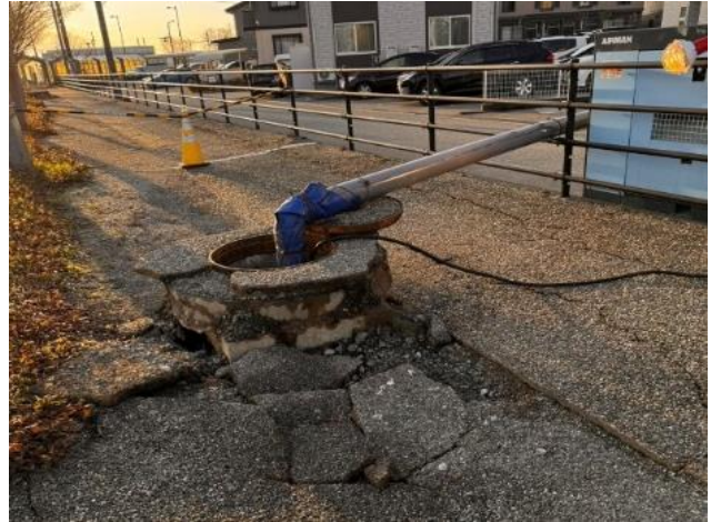
▲仮設配管・ポンプを設置した応急対応の状況
