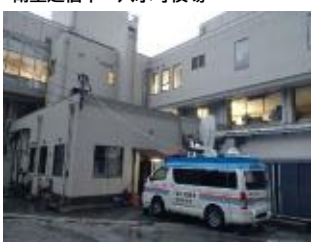
衛星通信車 穴水町役場
