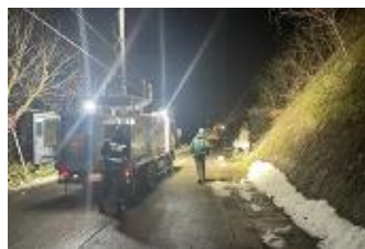
照明車 輪島市 夜間照明
