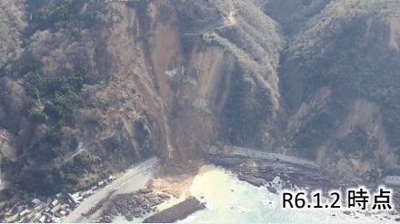
写真④ 国道249号法面崩落
