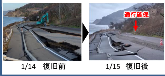
写真③ 国道249号緊急復旧完了
