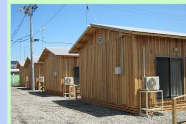
木造仮設住宅（設置例）
