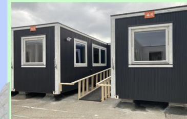
ムービングハウス（輪島市完成例）
