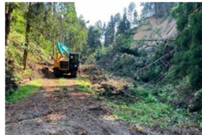
林道(工事用道路)啓開状況
