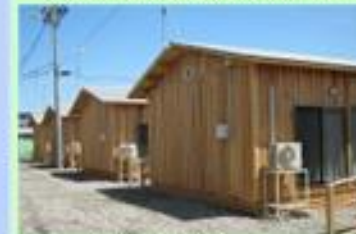
木造仮設住宅（敦賀例）
