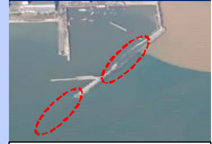
防波堤の損壊
