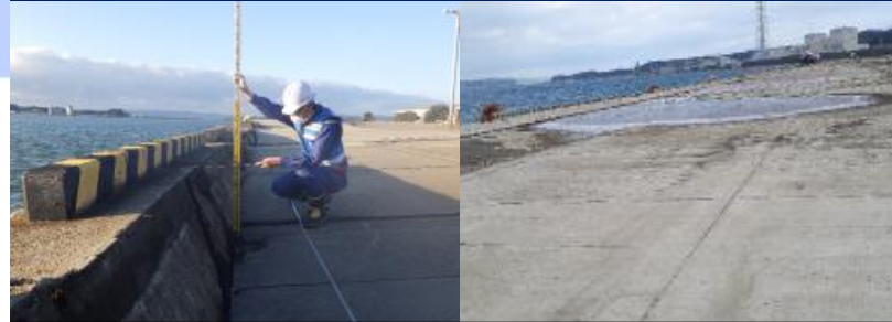
岸壁の沈下
