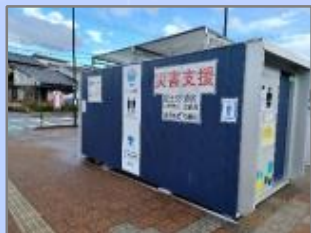
⑬トイレコンテナ（搭載型）
