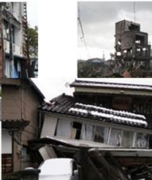
木造建築物の倒壊状況（穴水町）
