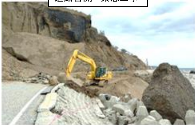
道路啓開 緊急工事
