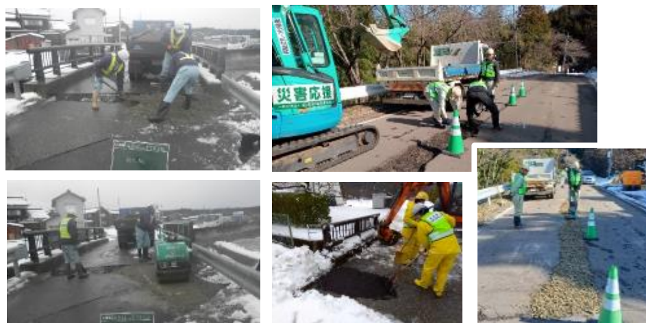
道路の段差解消作業
