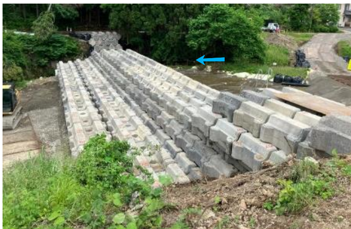
ブロック堰堤 設置完了
