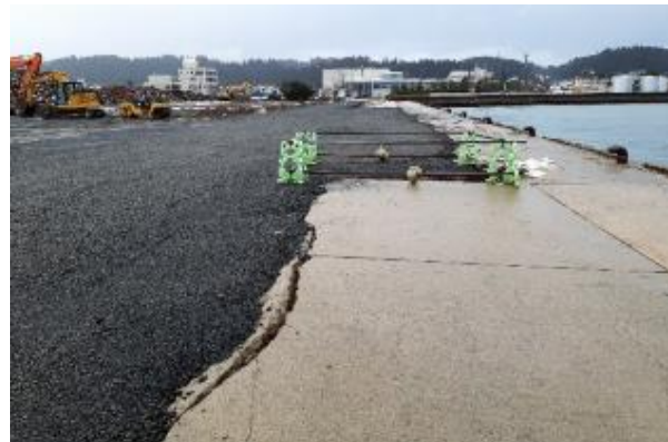
応急復旧後の状況
