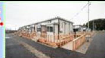
プレハブ住宅（輪島市完成例）
