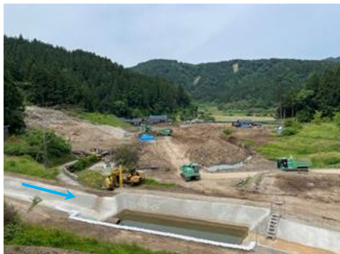
崩壊地末端部 排土状況
