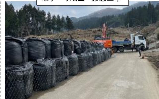
地すべり地区 緊急工事
