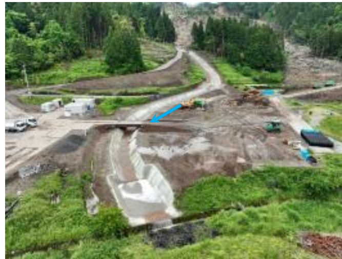
仮排水路 整備完了
