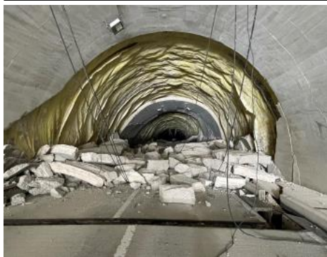
国道249号大谷トンネル（珠州市）
