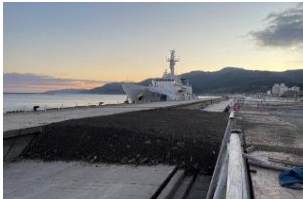
応急復旧後の状況
