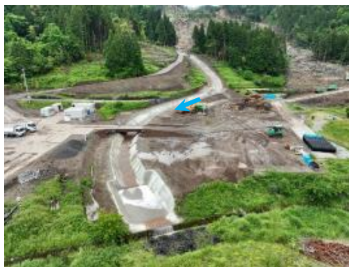
応急対策工事状況（紅葉川） 仮排水路設置完了
