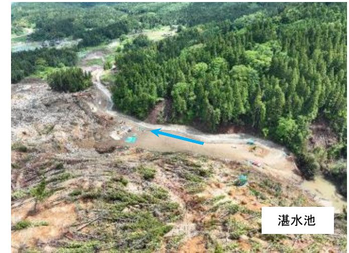
仮排水路 整備完了
