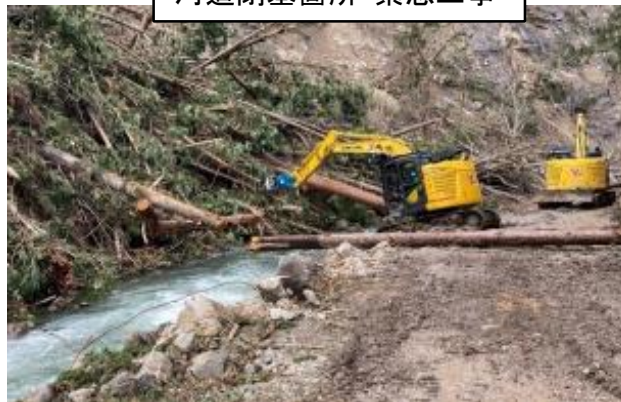
河道閉塞箇所 緊急工事
