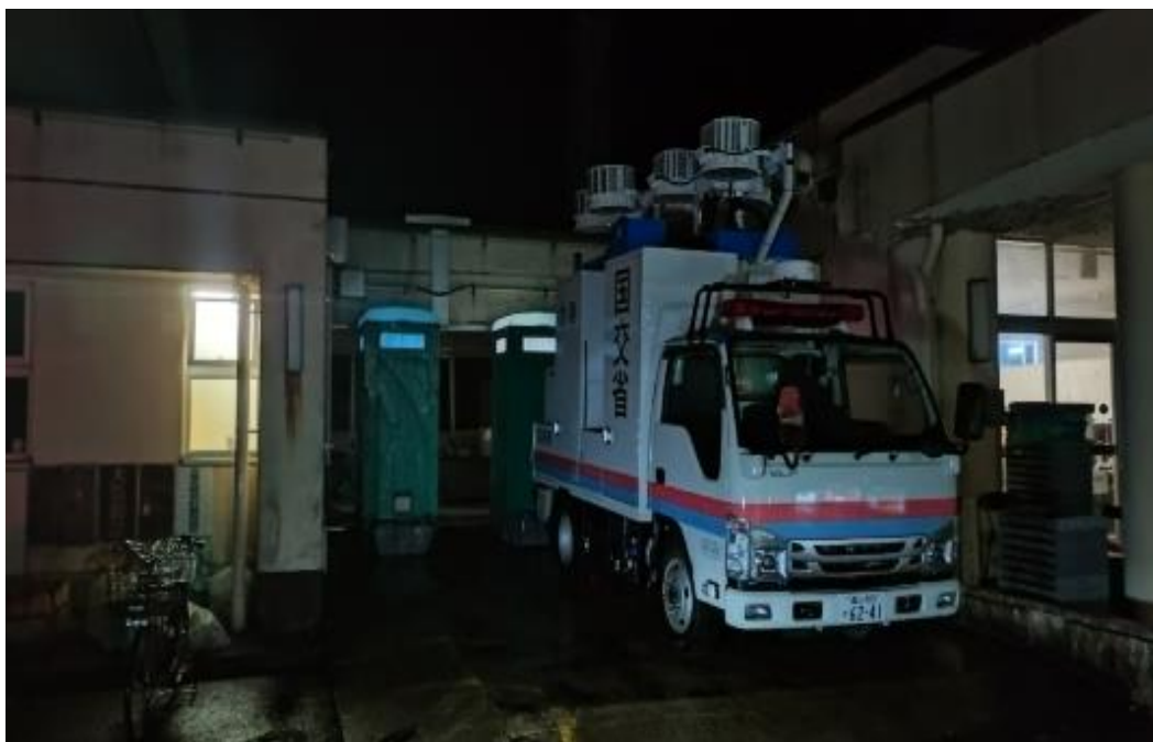
旧本小学校への電源供給
