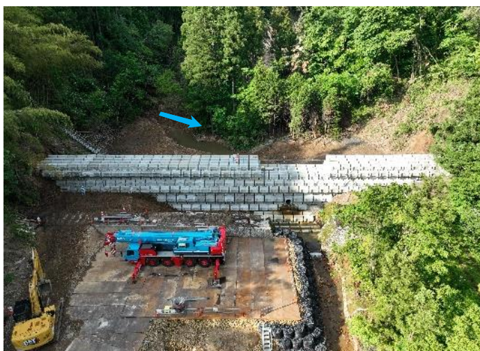
ブロック堰堤 設置完了
