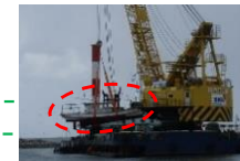
啓開作業の状況（2/27）
