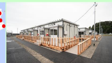
プレハブ住宅（輪島市完成事例）
