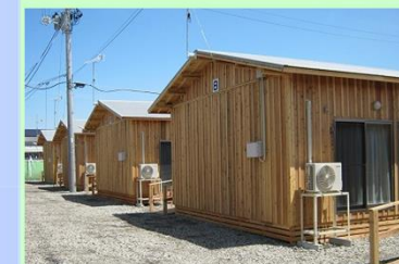
木造仮設住宅（設置例）
