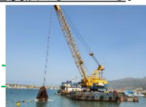
小型船だまりの浚渫作業の状況（4/19）
