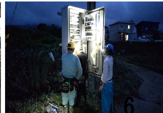
揚水機能の復旧確認
