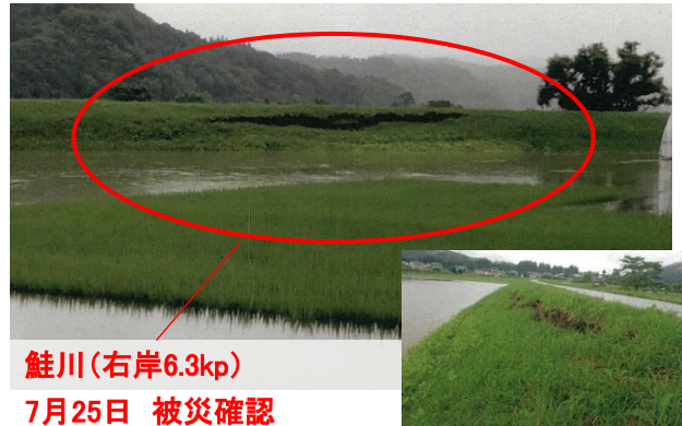
7月25日 被災確認 堤防亀裂(裏法崩れ) L=70m
