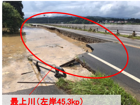
7月26日 被災確認 堤防欠損 L=100m
