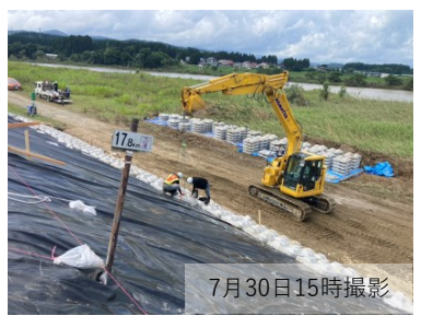
7月25日 被災確認 堤防亀裂(裏法崩れ) L=70m
