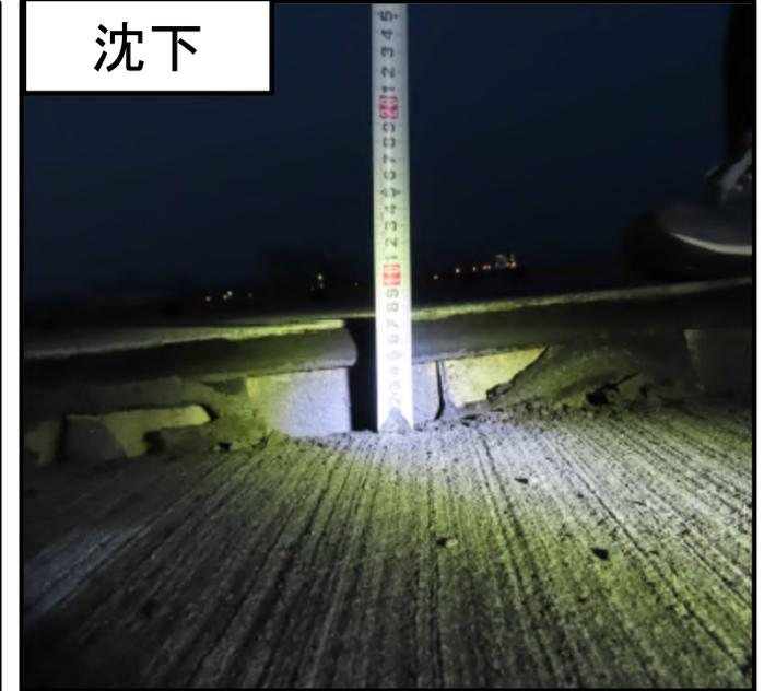
震度5弱を観測した志布志港新若浜地区コンテナターミナルのふ頭用地(新若浜地区コンテナターミナル)の一部で液状化や沈下が発生。
