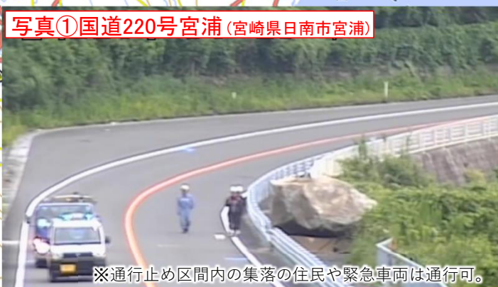
被災による通行止め区間 240811_1400 時点
