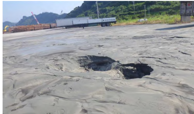
荷捌き地の液状化
