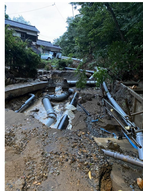
一部破損した管路
