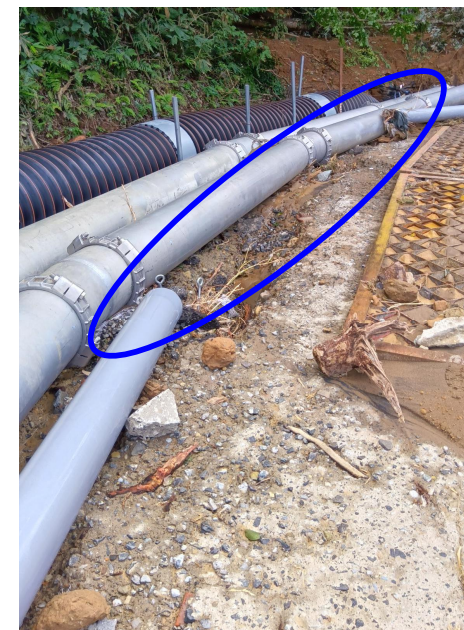
一部破損した仮設管路（管の抜け）
