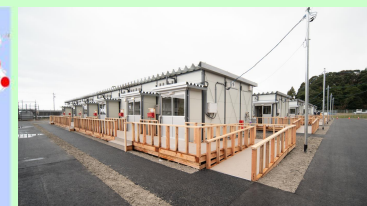
プレハブ住宅（輪島市完成事例）
