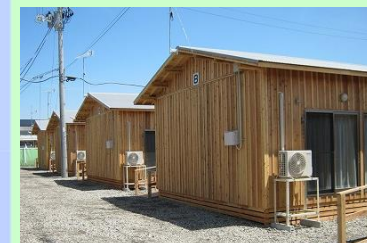
木造仮設住宅（設置例）
