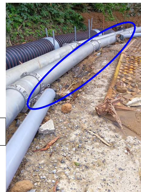
一部破損した仮設管路（管の抜け）
