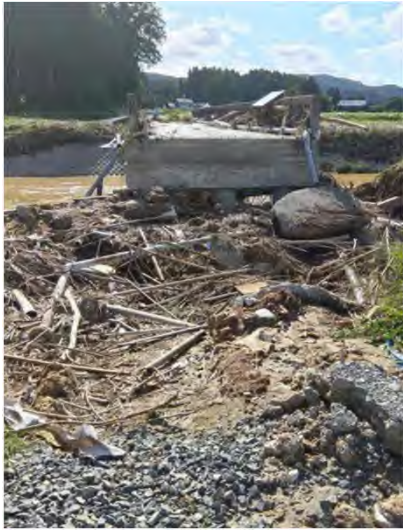
< 珠洲市若山町 > 添架管破損
