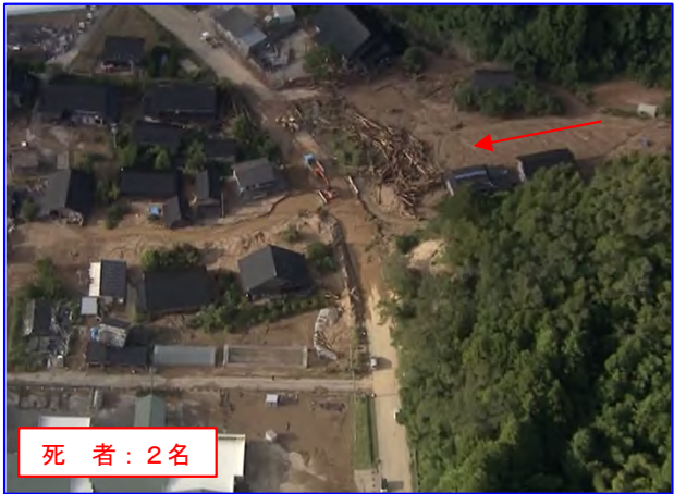
9/21 土石流等 ①石川県輪島市町野町寺地
