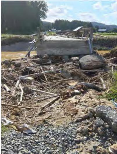
＜珠洲市若山町＞ 添架管破損
