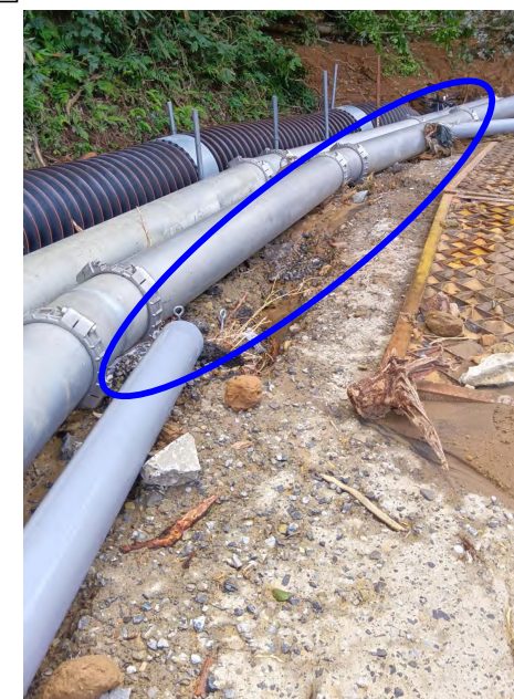
一部破損した仮設管路（管の抜け）
