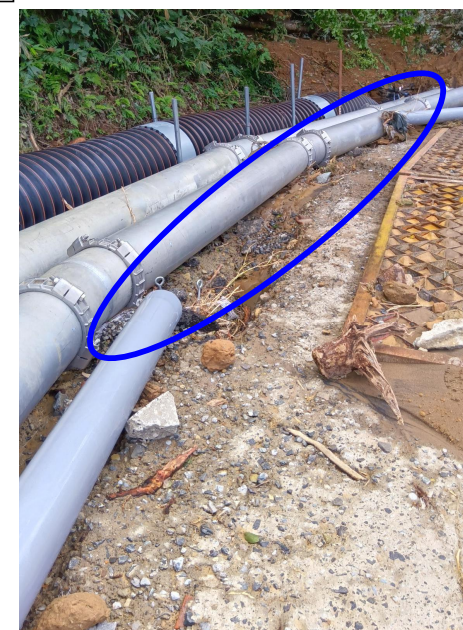
一部破損した仮設管路（管の抜け）
