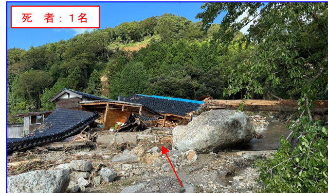
9/21 土石流等 ②石川県輪島市町野町南時国
