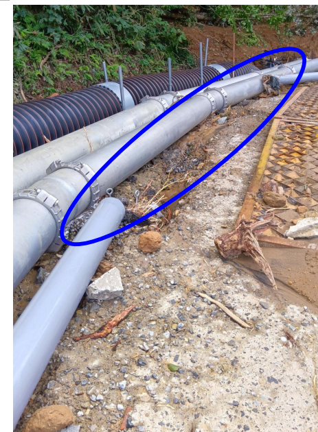
一部破損した仮設管路（管の抜け）
