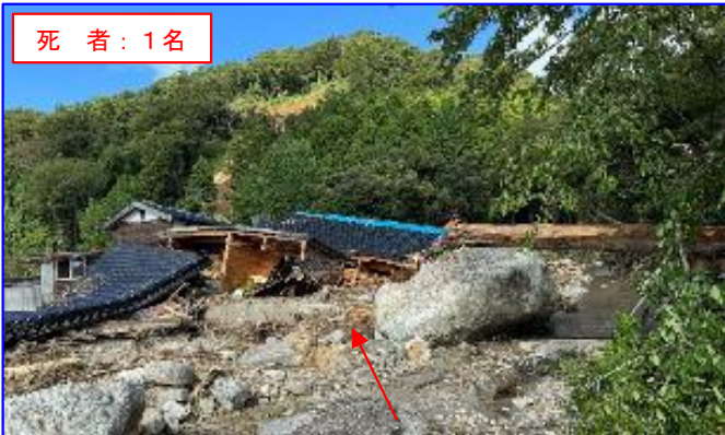
9/21 土石流等 わじまし まちのまちなみときくに ②石川県輪島市町野町南時国
