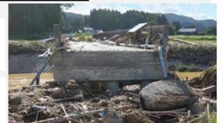
＜珠洲市若山町＞添架管破損
