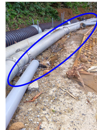
一部破損した仮設管路（管の抜け）
