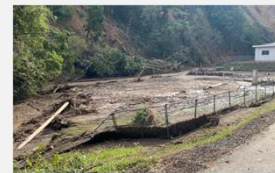
＜珠洲市大谷町＞ 大谷浄水場沈砂池の埋塞
