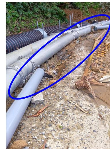
一部破損した仮設管路 (管の抜け)
