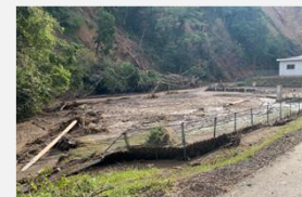
＜珠洲市大谷町＞ 大谷浄水場沈砂池への土砂流入
