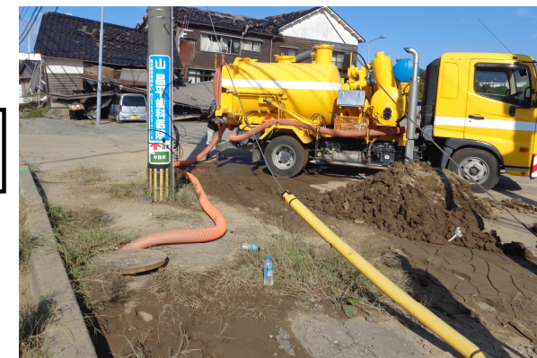
バキューム車による汚水の吸引・運搬
