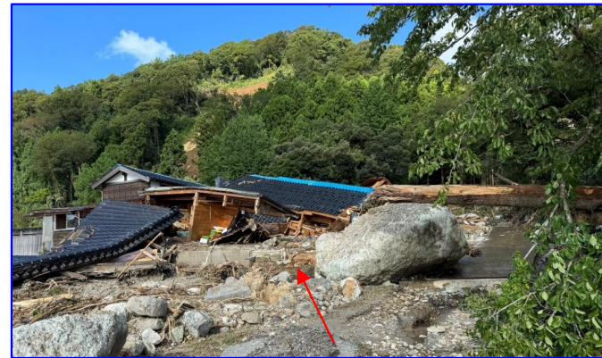
9/21 土石流等 ②石川県輪島市町野町南時国
