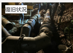
＜輪島市河井町＞仮設管抜け
