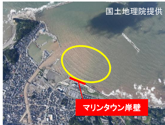
マリントウン岸壁
