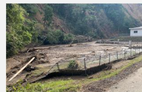
＜珠洲市大谷町＞ 大谷浄水場沈砂池への土砂流入
