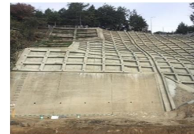
斜面の崩壊防止対策 (コンクリート枠による斜面の補強)
