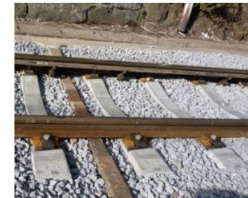
線路設備 (軌道改良(PCマクラギ化))
