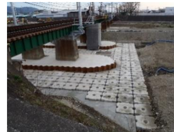
橋りょうの流失・傾斜防止対策 (ブロックによる橋脚の補強)
