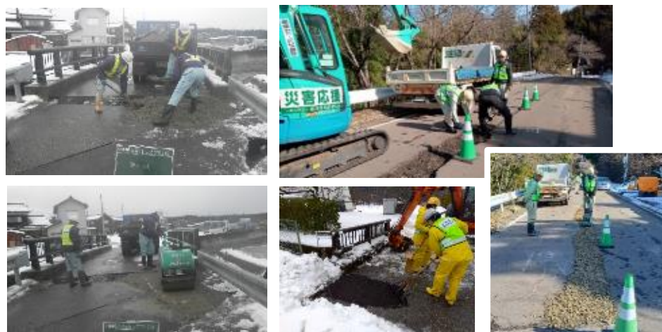
道路の段差解消作業
