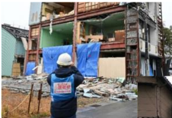
建築物の損壊状況（七尾市）
