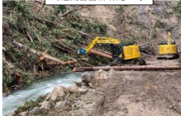
河道閉塞箇所 緊急工事
