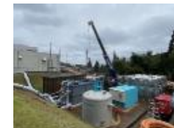
可搬式浄水装置の設置 （珠洲市）
