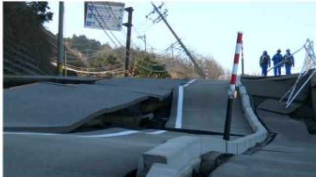
国道249号道の駅千枚田付近（輪島市）
