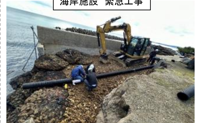
海岸施設 緊急工事
