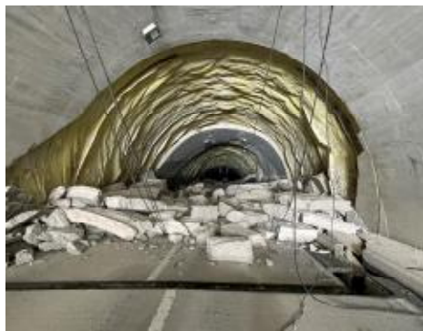
国道249号大谷トンネル（珠州市）
