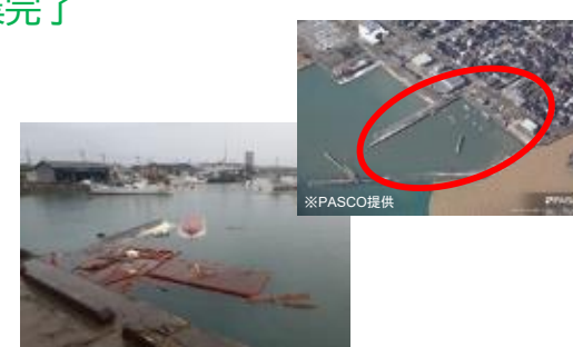
船だまりの被害状況
