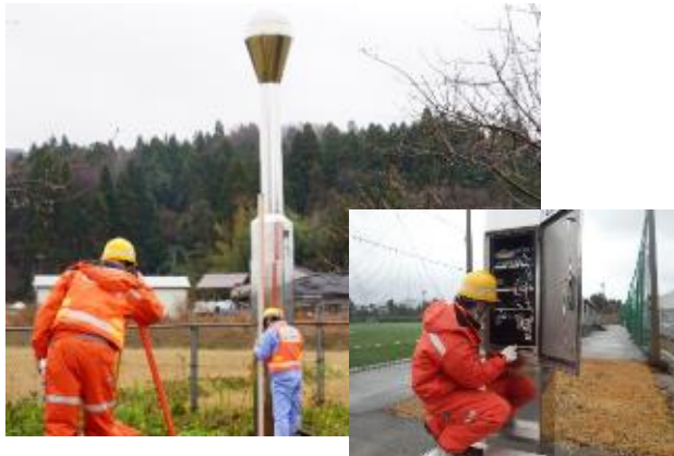
電子基準点の点検
