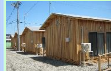
木造仮設住宅（設置例）
