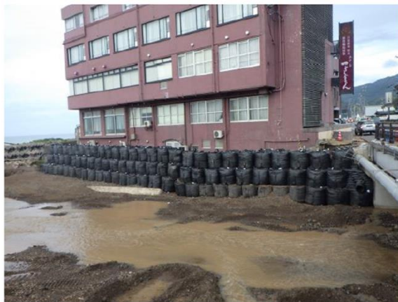
海岸護岸の一部が被災(応急復旧完了(10/15))
