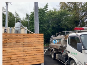
<受水槽への給水 (珠洲市折戸)>
