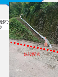
<土砂崩落のため迂回ルートへ露出配管の 設置により応急復旧(珠洲市上戸町)>
