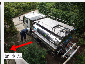
<配水池への給水(運搬送水)により早期復旧(輪島市惣領)>
