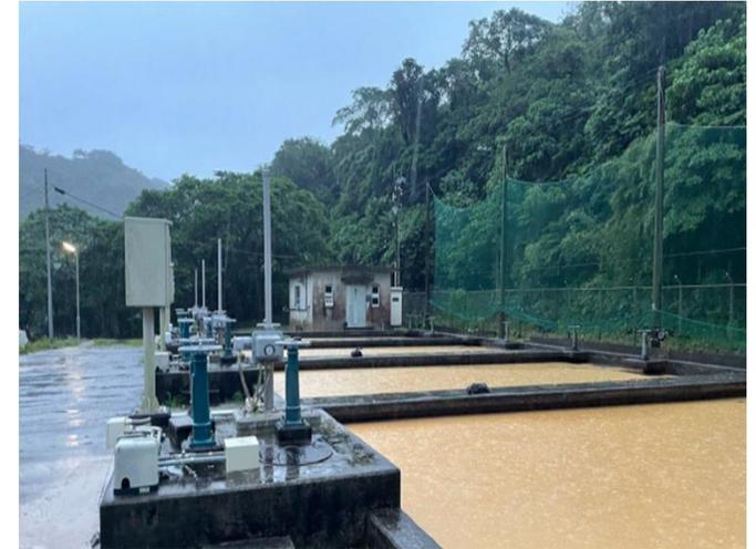
浸水によるろ過池への土砂の流入
