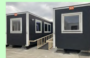
ムービングハウス（輪島市完成例）
