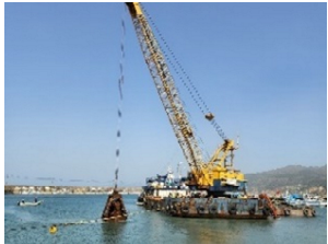
小型船だまりの浚渫作業の状況(R6.4)
