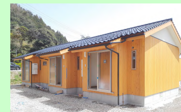
木造仮設住宅（輪島市完成例）
