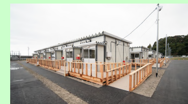
プレハブ住宅（輪島市完成例）
