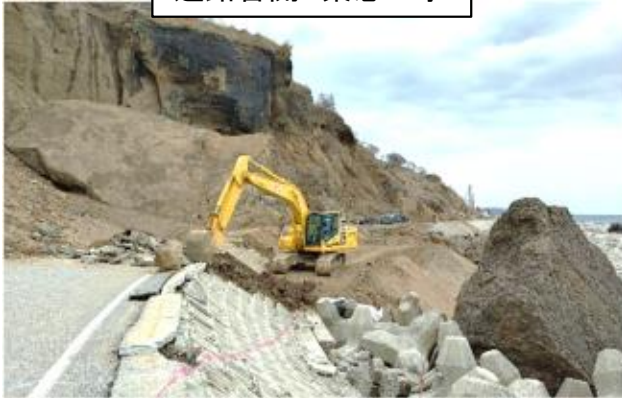
道路啓開 緊急工事
