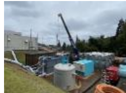
可搬式浄水装置の設置 （珠洲市）
