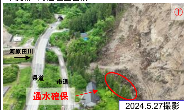
下流部 河道埋塞箇所
