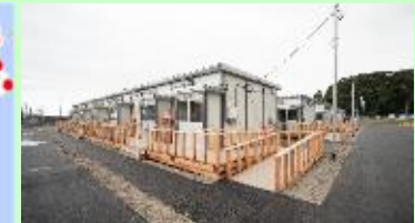
プレハブ住宅（輪島市完成事例）
