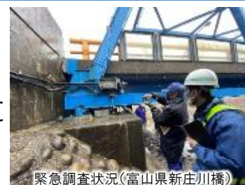
緊急調査状況(富山県新庄川橋)
