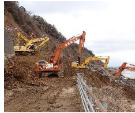
<崩落土撤去の状況>
