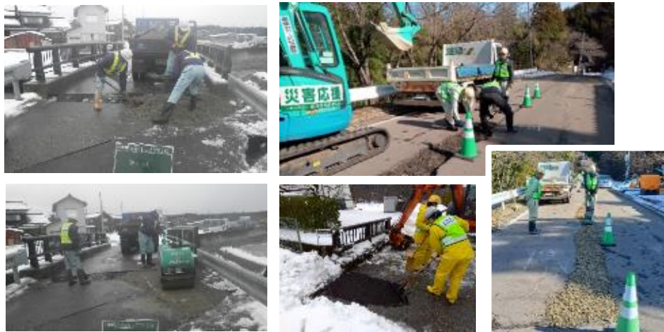
道路の段差解消作業
