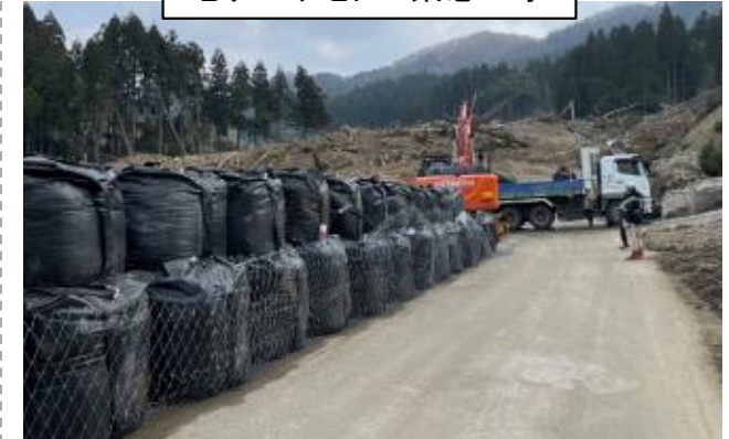
地すべり地区 緊急工事
