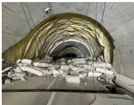
国道249号大谷トンネル（珠州市）
