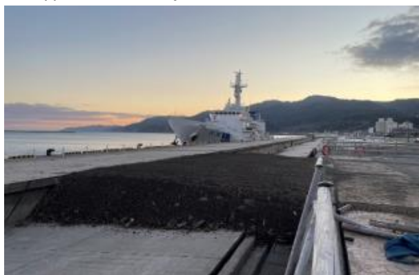
応急復旧後の状況
