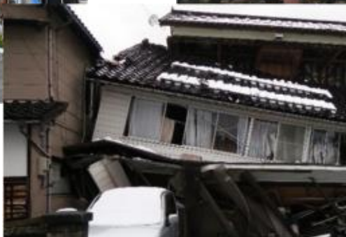
木造建築物の倒壊状況（穴水町）
