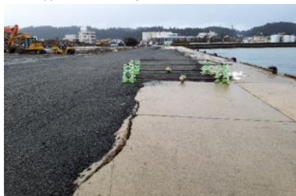
応急復旧後の状況
