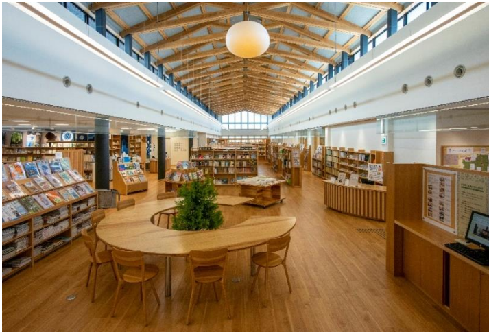
智頭杉のトラスと家具（開架室）
