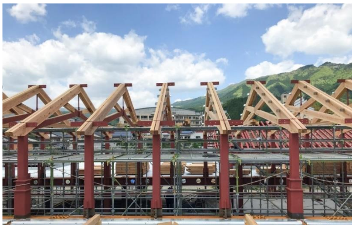
施工中の合成トラス
