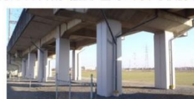
大規模地震対策（新幹線高架橋柱）
