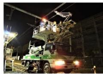
架線設備の検査
