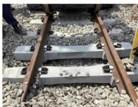
軌道構造強化 (弾性PC化)
