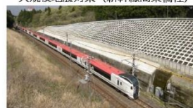
切取り面工（吹付棒工）
