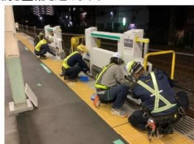
ホームドア工事
