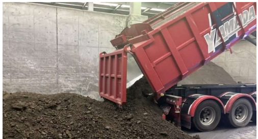
令和5年台風2号「がれき・土砂」 (愛知県 2023年7月)
