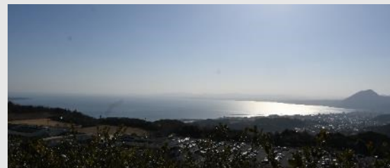
別府湾サービスエリア展望台からの広域景観
