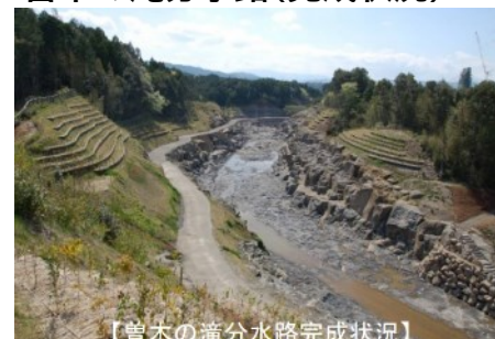
曾木の滝分水路(完成状況)
