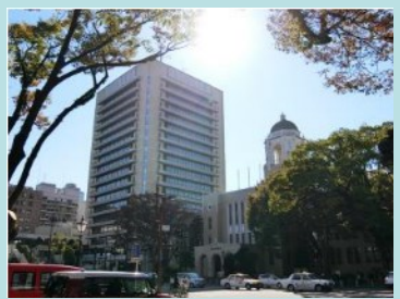
近代建築物と調和が図られている外壁色
